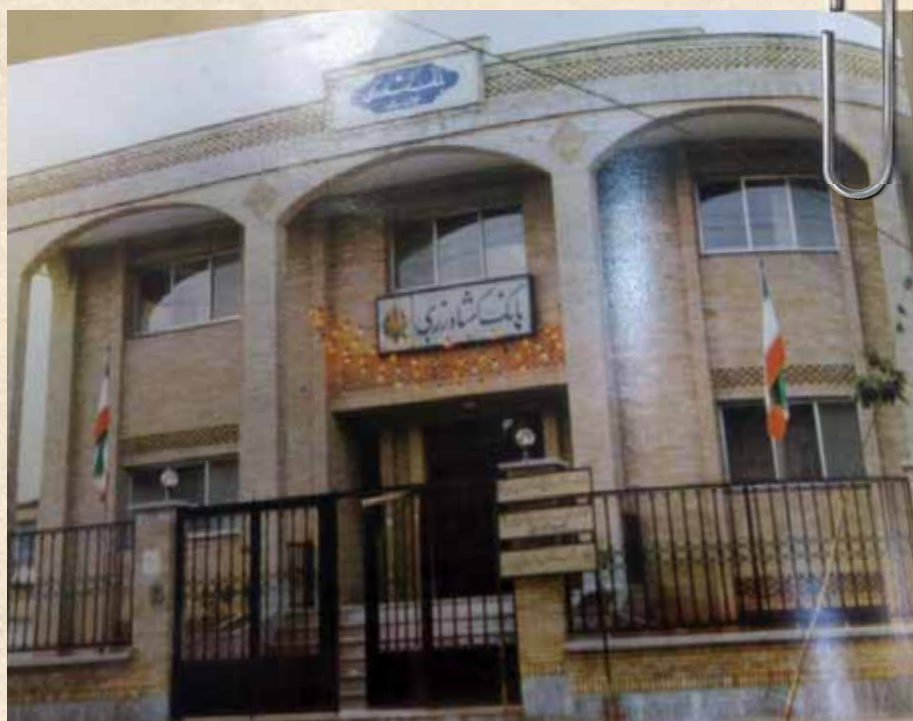
احداث ساختمان جدید بانک کشاورزی در کرمانشاه؛ سال ۱۳۷۷
