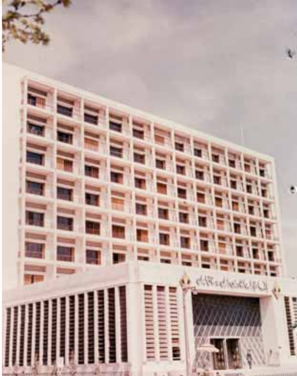
نمای جنوبی ساختمان اداره مرکزی و شعبه مرکزی مشرف به پارک شهر
